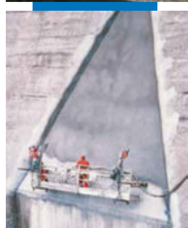
Нанесение Mapelastic на дамбу распылением
