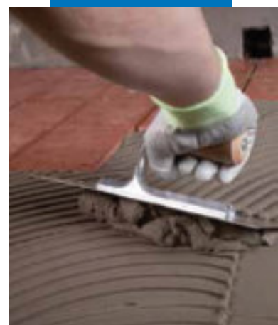
Нанесение Granirapid на гидроизоляцию Mapelastic на террасе
