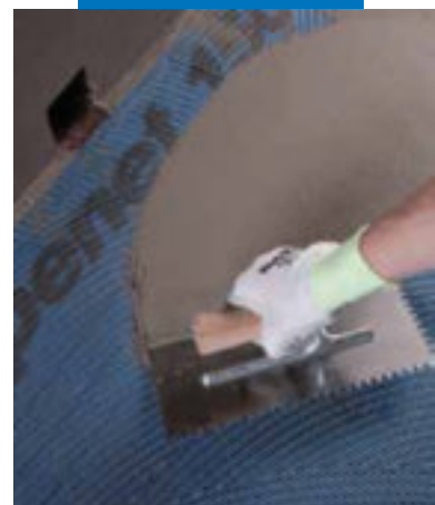
Нанесение Mapelastic на Mapenet 150 R
