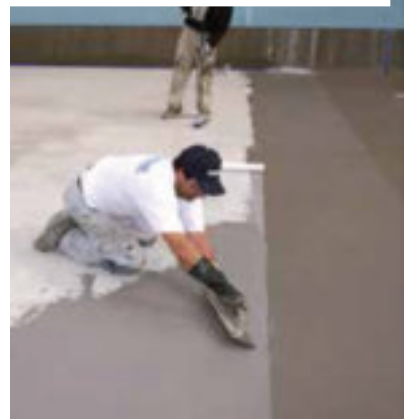
Гидроизоляция бассейна с применением Mapelastic
