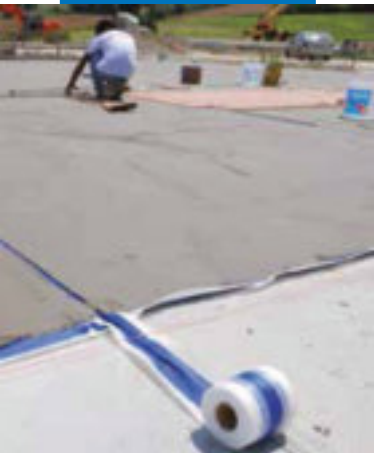
Гидроизоляция стяжки с применением Mapelastic и Mapeband
